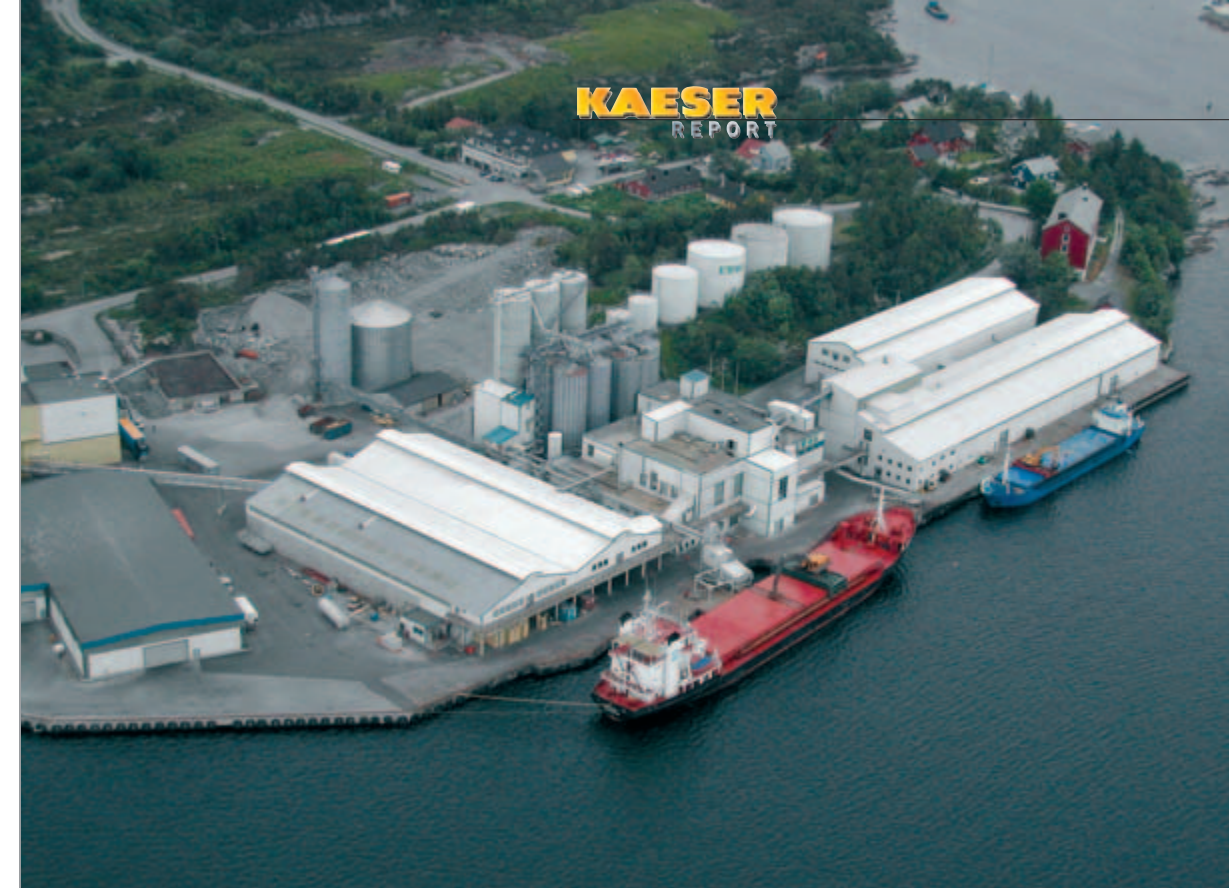
Fôret transporteres pneumatisk hele veien fra ekstruderne, videre til en lagringssilo på kaia og derfra til lagringstanger på forråtene
