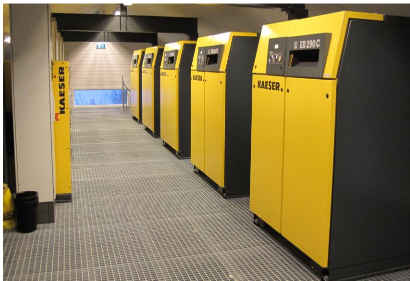
Maskinparken består av ti sett blåsemaskiner i to trinn med mellomkjøling, totalt tjue blåsemaskiner med et overordnet samkjøringssystem.
